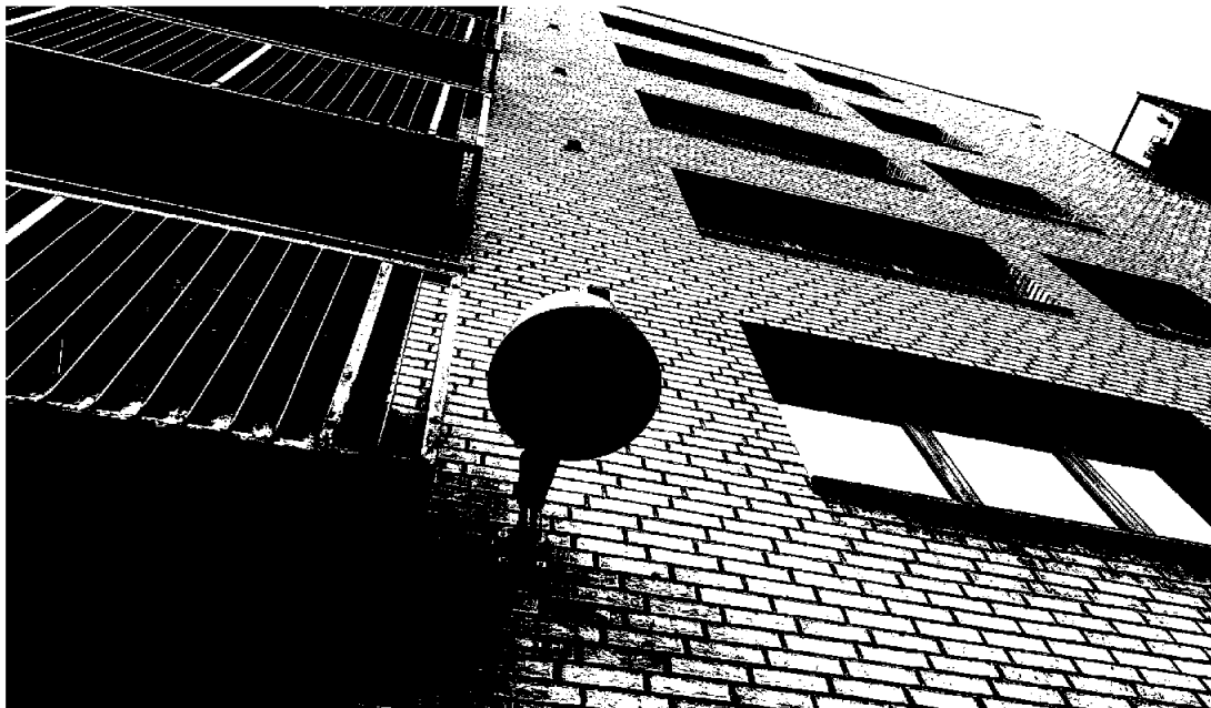
Belysningsutstyr på fasade
