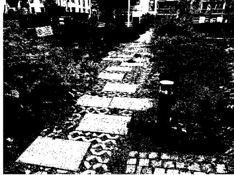
Pullerbelysning er utsatt for jordfeil
