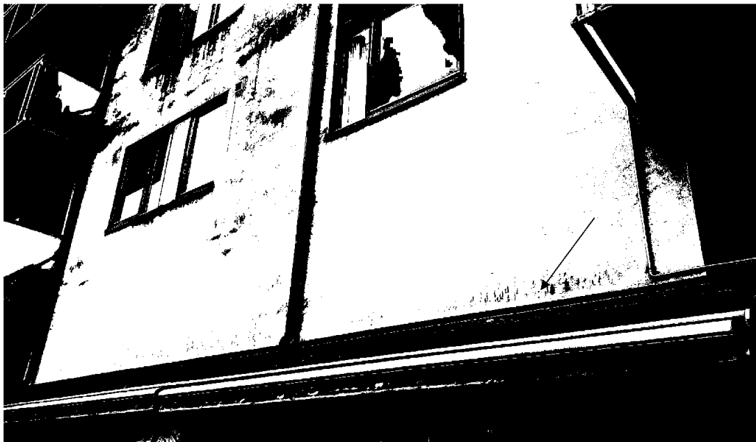
Fasader må rengjøres og eventuelt overflatebehandles i etterkant. Hull må forsegles
