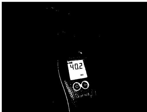
Mellom 40-50% fuktighet funnet i åser og undertak. Tegn på lekkasje.
