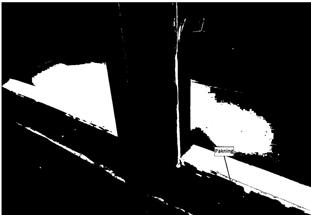
Bilde 7, pakninger er delvis malt igjen. Pakning kan skiftes ut.
