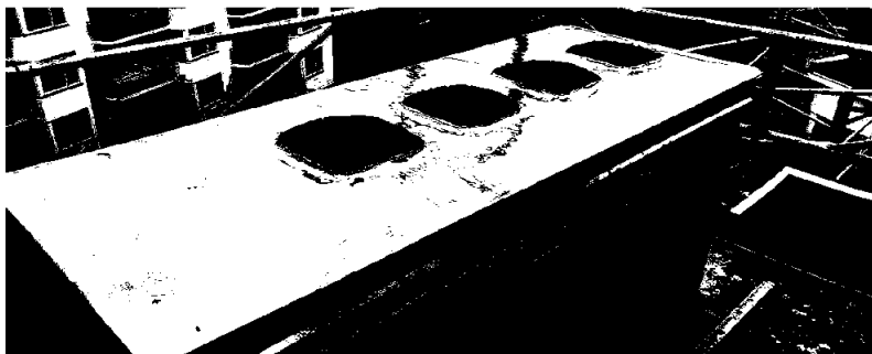
Bilde 16. Eksempel på pipetopp med sprangblikk og bly.
