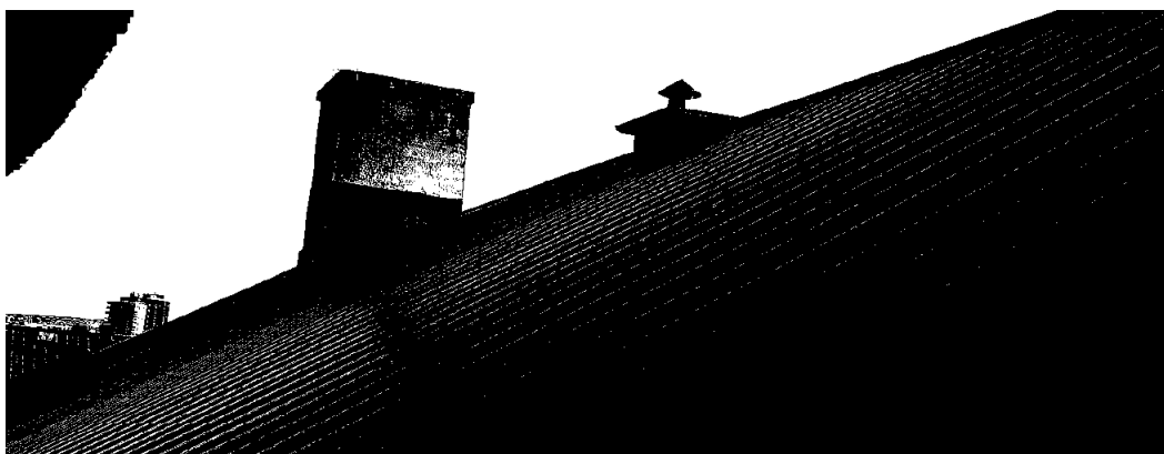
Bilde 16. Taker er lagt om, og piper er murt opp på nytt over i tak i 2013, jf. mottatt dokumentasjon. Det ble ikke registrert toppbeslag på piper.
