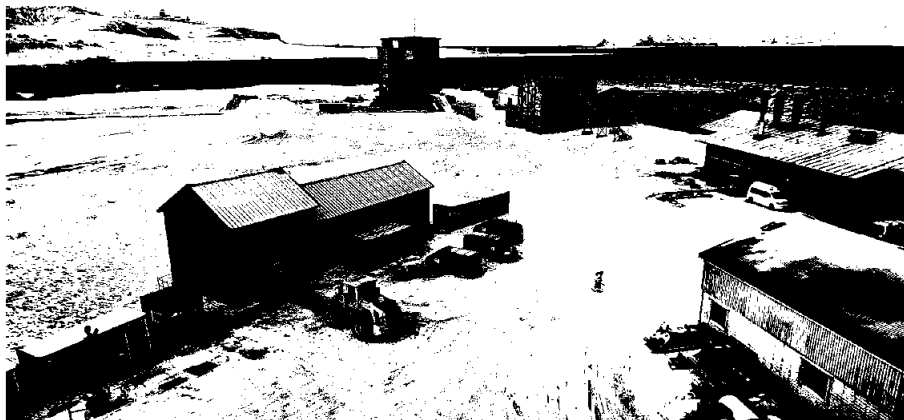
Reservekraftanlegget under oppføring (til venstre i bildet). Tak, vegger, vinduer og porter er på plass. Oktober. Foto: Johannes Lipphardt.
