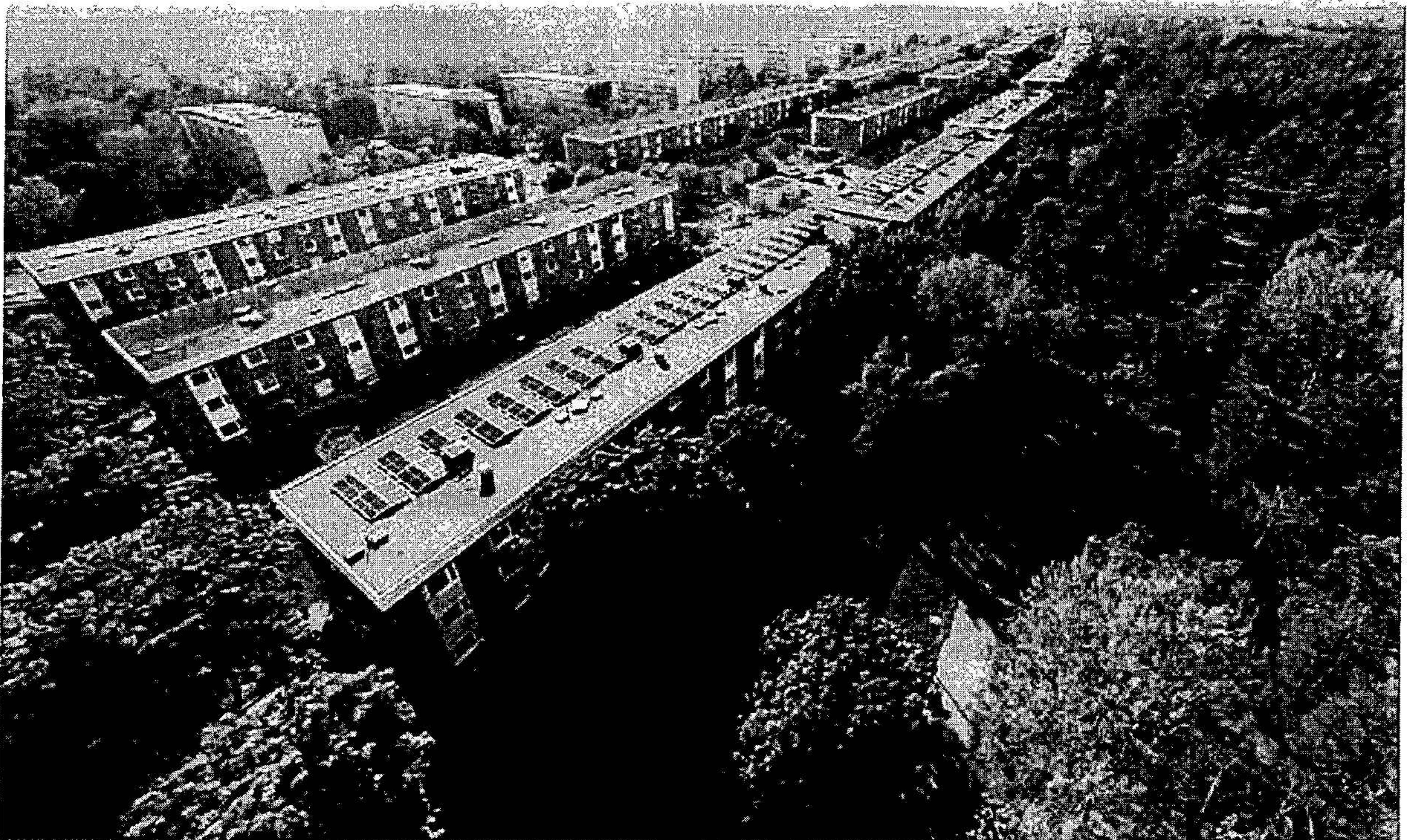
På 28 tak i Bagarmossen anlägger Stockholmshem Stockholms största solcellspark. Under 2023 blev första etappen klar. När hela anläggningen på 5 500 m 2 solceller är i drift kommer den producera 900 megawattimmar el årligen. Flygfoto: Tomi Heder.
