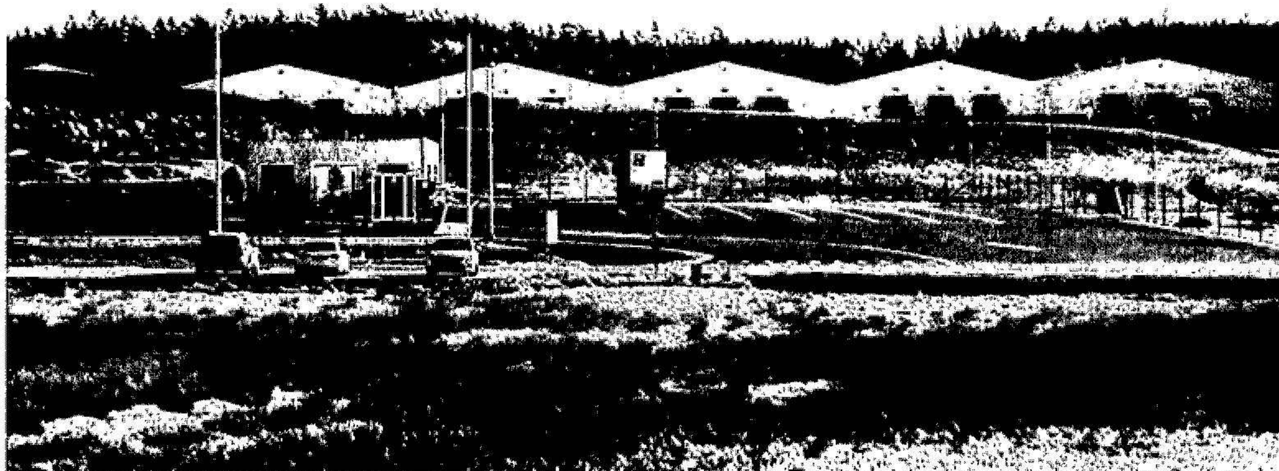
På bilden syns de nya lagerhallarna på Vedkullen vid Gategård som anslutits till vårt fjärrvärmenät under året.
