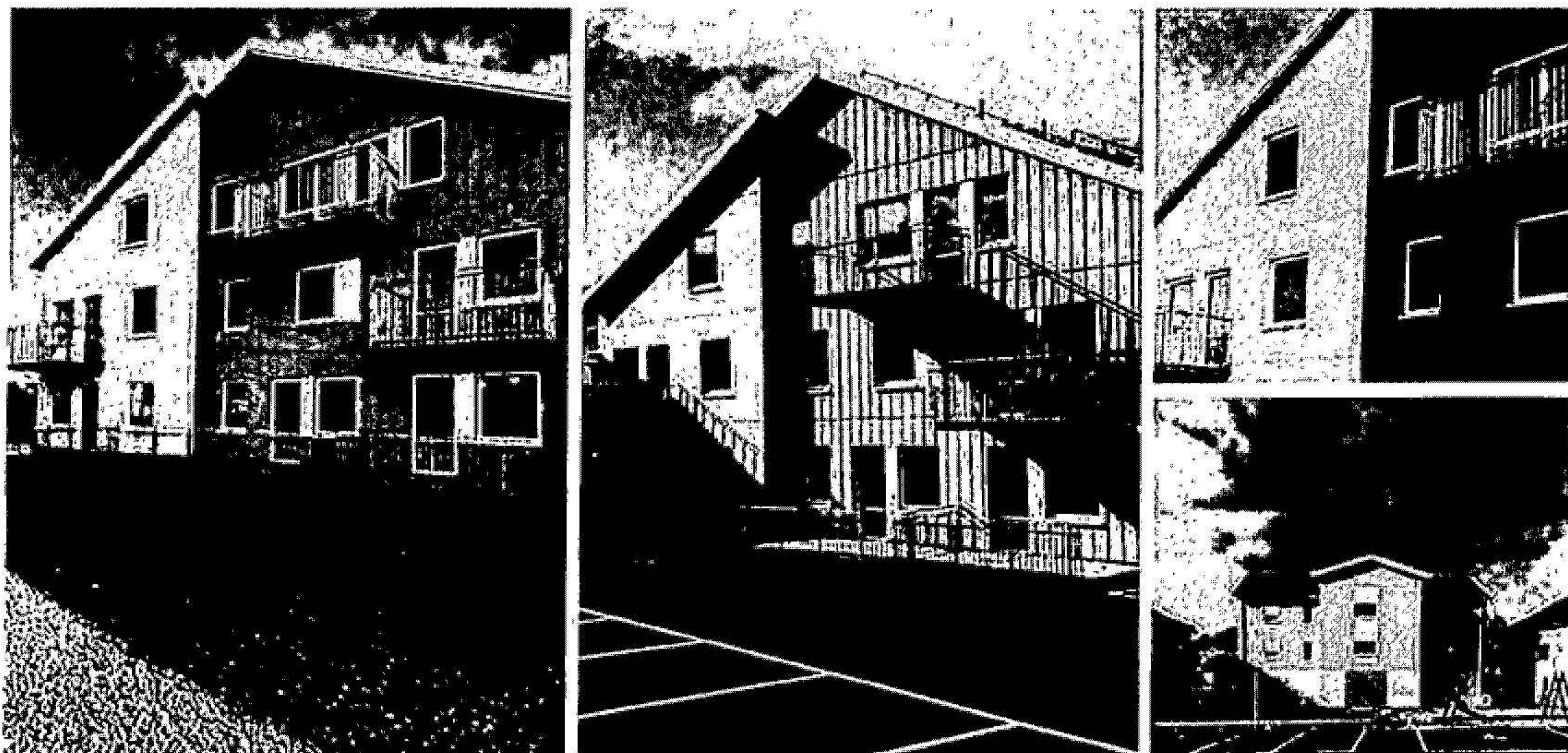
Projekt Björkdungen (2023) är Tornstadens pilotprojekt med Tornstadenhuset och utföll mycket väl.
