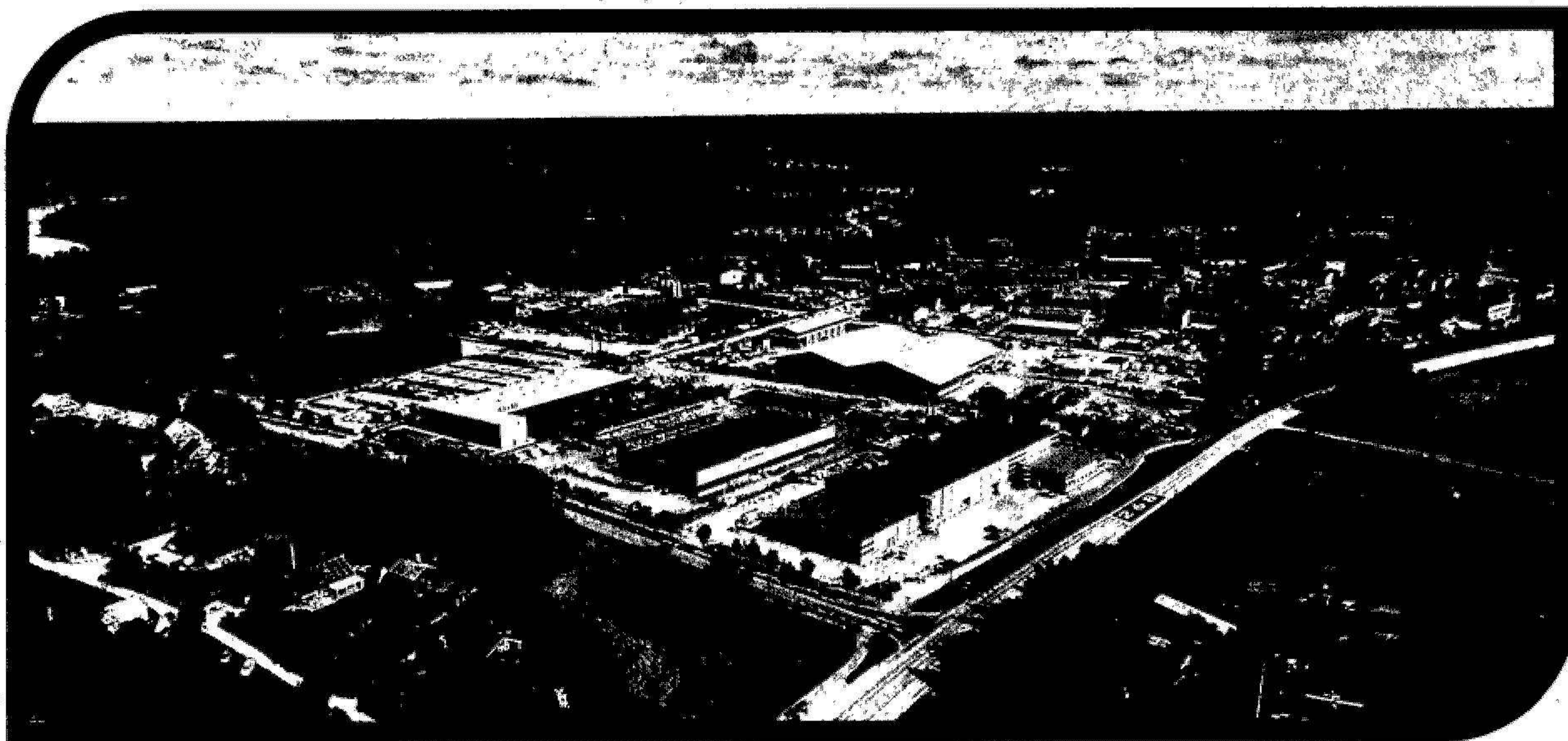
Lindövägen 2 - 10, Vargmötesvägen 9, Vallentuna kommun (Färdigställdes bl a 2018, 2022 och 2024)
