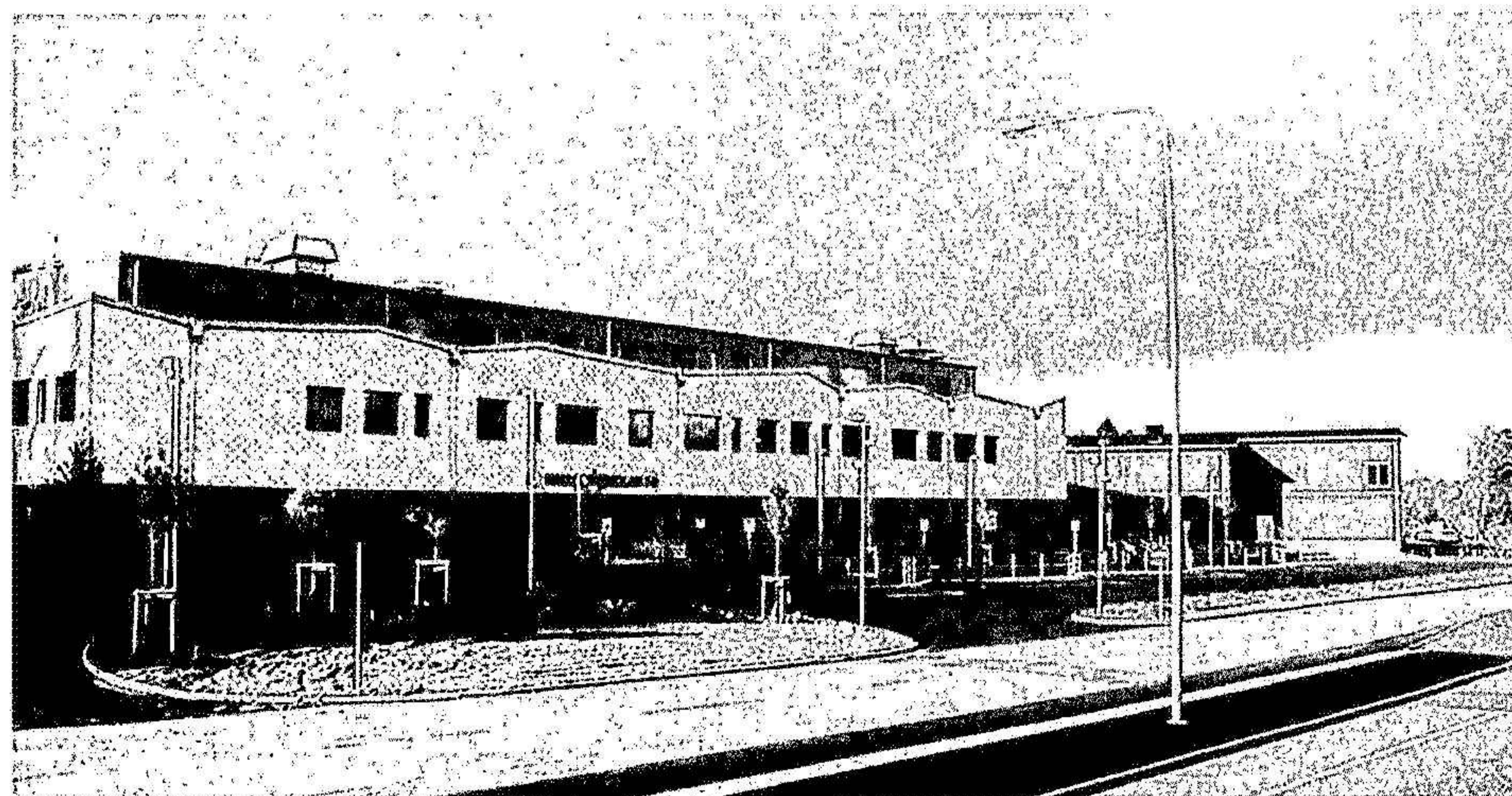
På bilden syns den nya högstadieskolan på Hallerna som öppnade för elever under hösten. Skolan värms givetvis med vår fjärrvärme.
